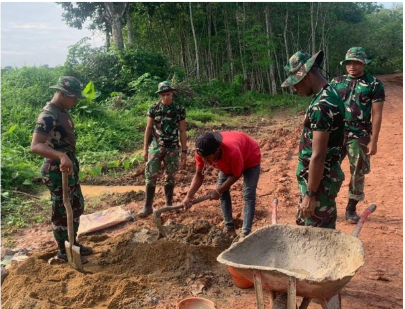
Anggota Satgas dan Warga Bahu Membahu Selesaikan Pemasangan Gorong-gorong
