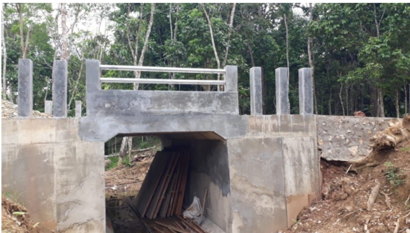
Jembatan Box Culvert Masuk Tahap Finishing
