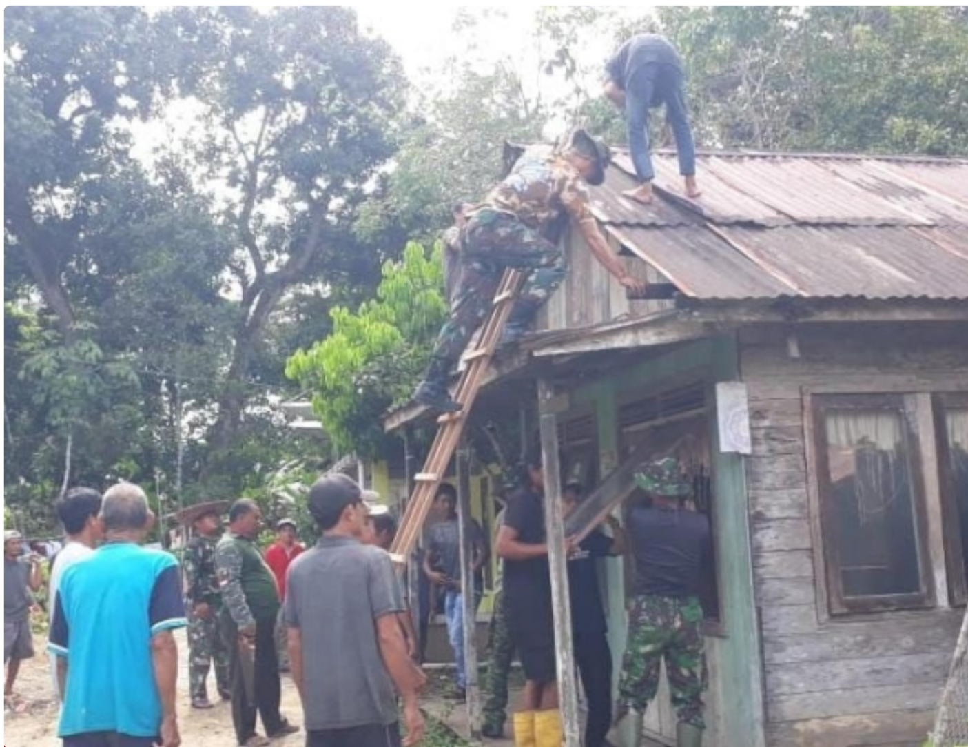
Anggota Satgas TMMD ke-115 Kodim 1008/Tabalong Gotong Royong Bedah Rumah
